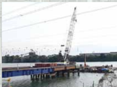
工所用仮設橋設置状況(水島地区側)
