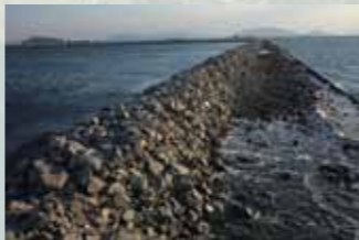
浚渫土処理護岸捨石施工状況
