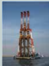
サンドコンパクションパイル施工状況
