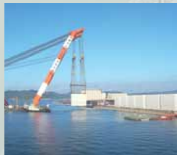
「武蔵」によるケーソン設置状況
