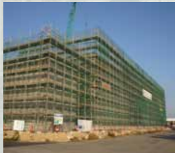
ケーソン製作状況
