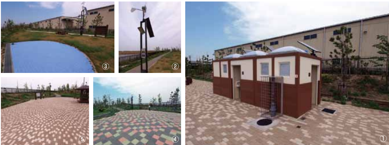
写真①【H23年3月に完成したトイレ。屋根に設置したソーラーパネルで電力をまかなう。】写真②：【ハイブリッド照明。太陽光発電、風力発電、それぞれの現在の発電量が表示される。】写真③④⑤：【パーク内の舗装。それぞれ原材料が異なるがいずれもエコ製品を利用した舗装。】
