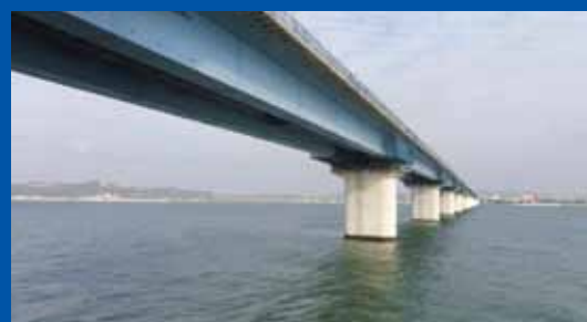
水島地区と玉島地区を結ぶ水島港臨港道路(新高梁川橋梁)工事状況
