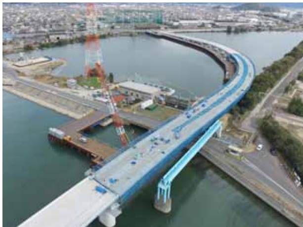
水島側の橋桁及び上部工の施工状況
