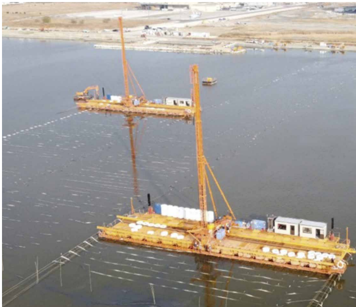
写真は船上から排水管を敷設している状況です。
