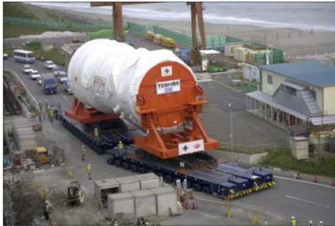
浜岡原子力発電所でのRPV(原子炉圧力容器) 輸送作業
