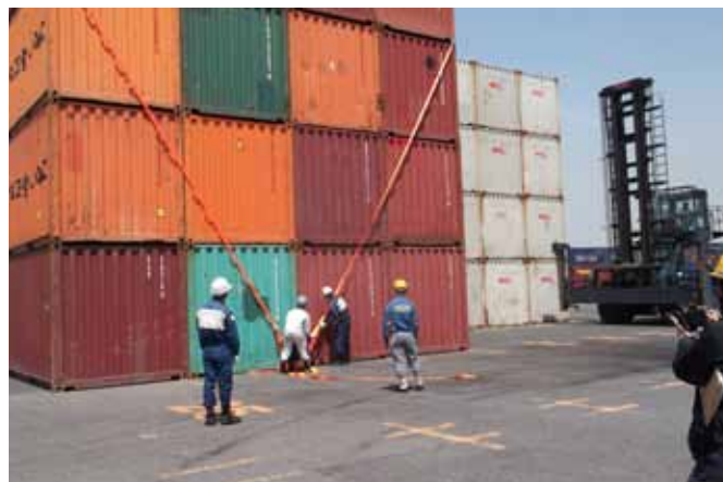
高梁川総合水防演習・倒壊防止のためのコンテナ固定作業
