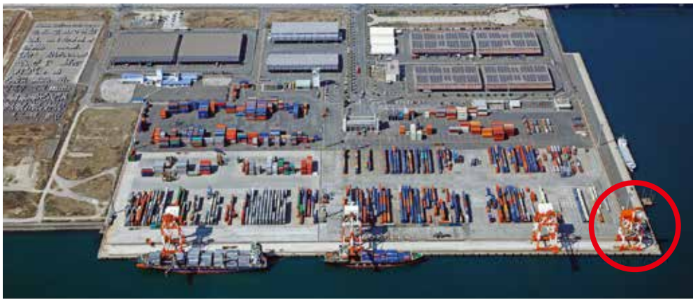
移設後のコンテナターミナル
