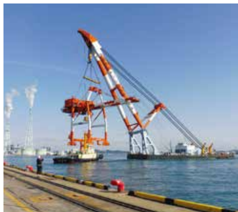
移動中のクレーン①
