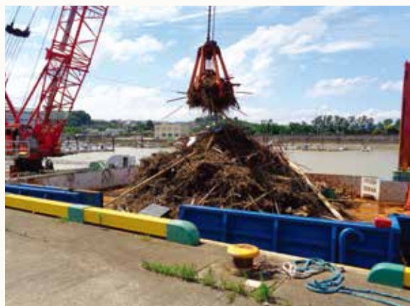
【乙島物揚場で漂着ゴミを撤去するクレーン付き台船】
