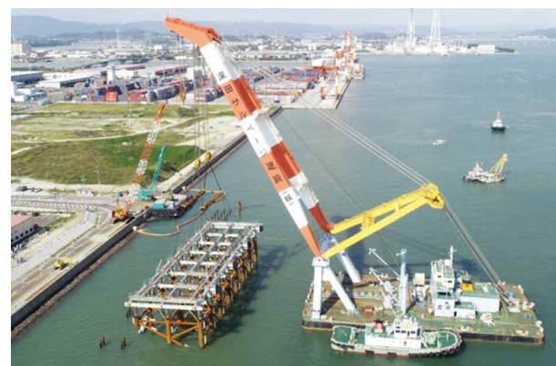
大型起重機船によるジャケット据付
