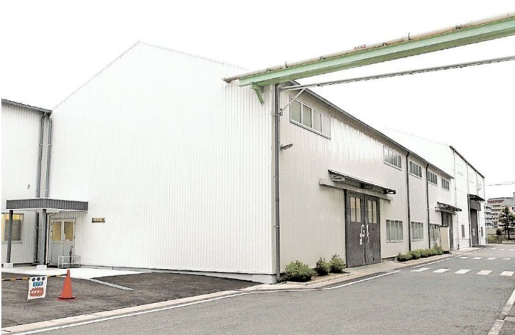
CFRPの加工設備を導入した本社工場
