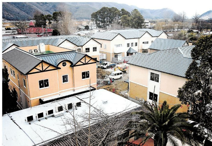
4月の利用開始を目指し、工事が進む旭川学園
