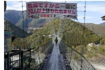
『ツナガル吊り橋』
