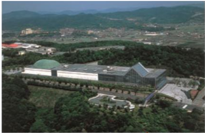
コンベックス岡山
