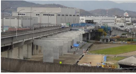
現在の箕島高松線下庄跨線橋
