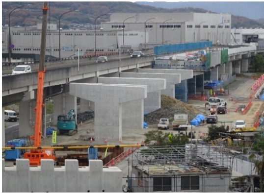
現在の箕島高松線下庄跨線橋
