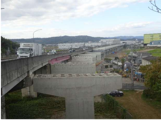
箕島高松線下庄跨線橋拡幅工事の現在の様子
